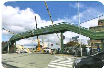
今はもう見られない風景 (八坂橋立橋)
