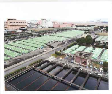
猪名川流域下水道原田処理場
