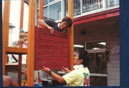
壁をとりつけます。子どもの頭がでないよう隙間は8センチです
