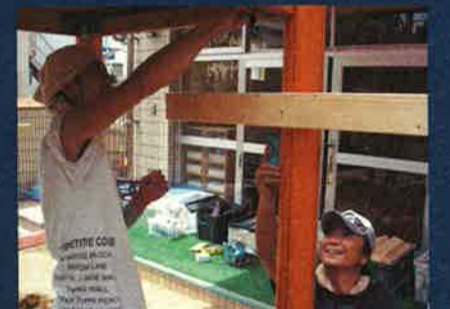
しっかりレベルを水平にして 床を取り付けます
